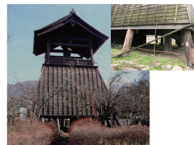
整備前の鐘楼
