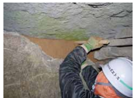
石室修復の様子
