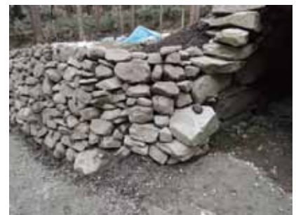
沈殿槽跡地につくられた石垣
