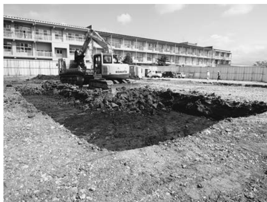
重機表土除去
