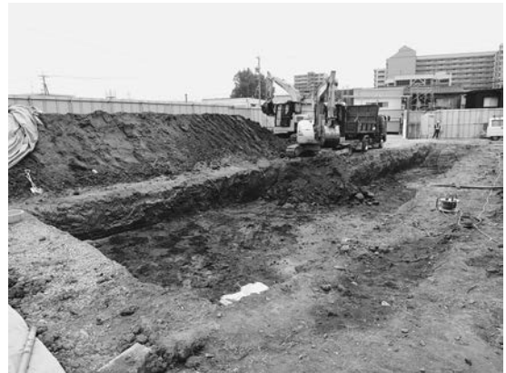
重機表土除去
