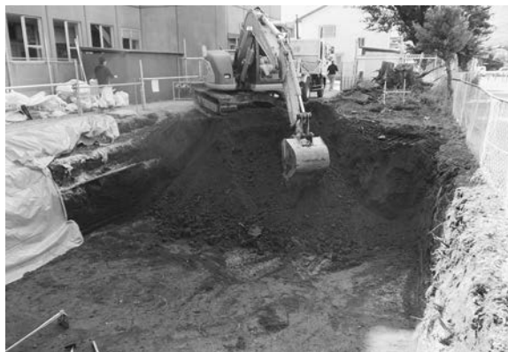
重機表土除去
